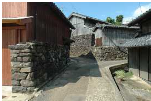
石塀を用いた倉庫建築
