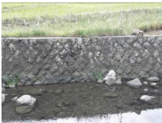
写真11 間知ブロック積みの護岸
