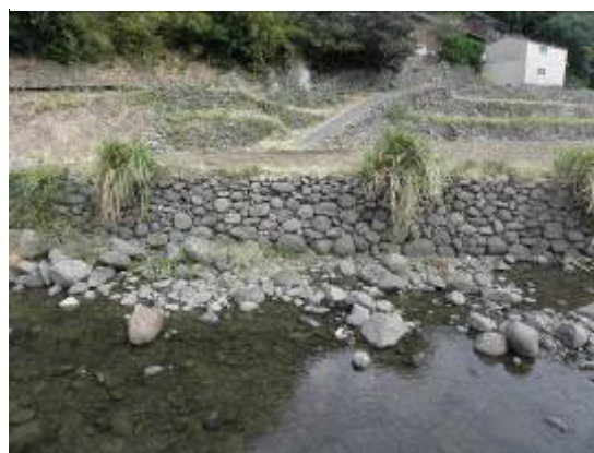
写真10 自然石空石積みの護岸
