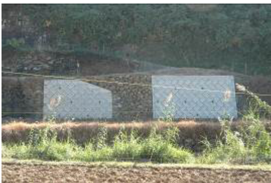
写真15 コンクリートブロック積み
