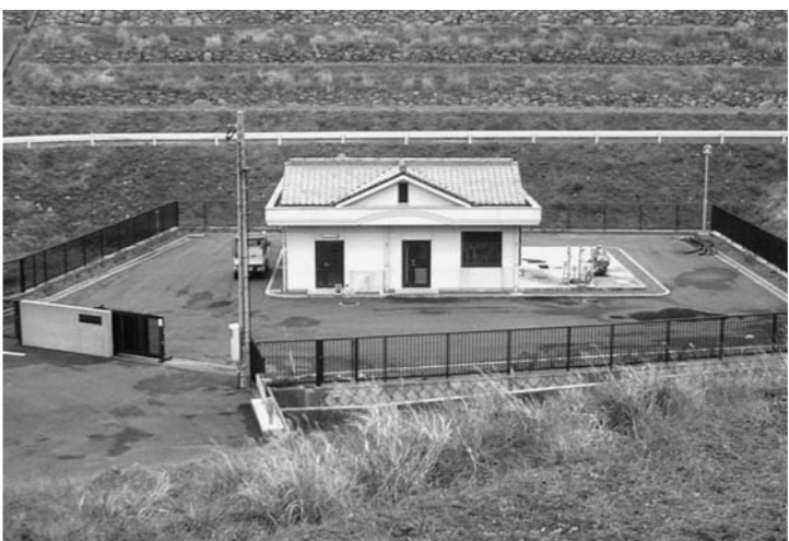
生月町御崎地区の汚水処理施設
