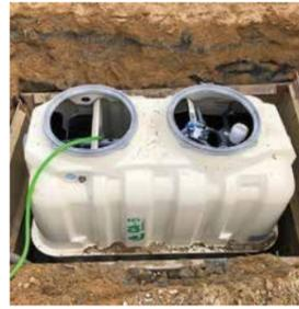
合併処理浄化槽は、台所排水や浴室排水、洗濯排水などの生活雑排水と、し尿を併せて処理できる個別汚水処理施設で、微生物などの働きを利用して汚水を浄化し、きれいな水にして放流するものです。
