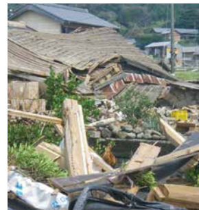
台風で倒壊した建物▲
