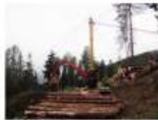
タワーヤード集材
