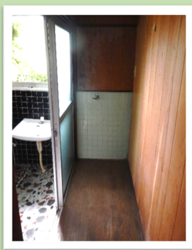
1階:洗濯機置場
