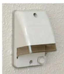
屋外用コンセント このコンセントであれば 防水プラグでなくても 差し込めます。
