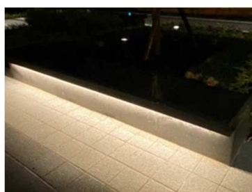
ベンチ下間接照明
