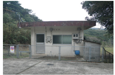
上大垣中継ポンプ場
