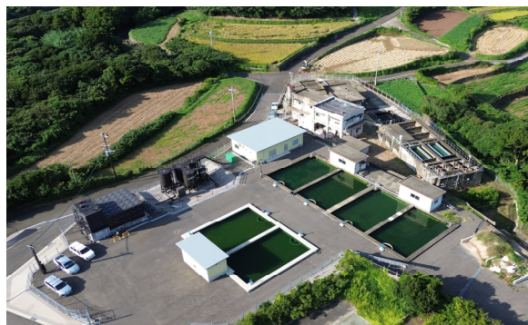
神の川浄水場
