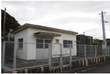
高越送水ポンプ場
