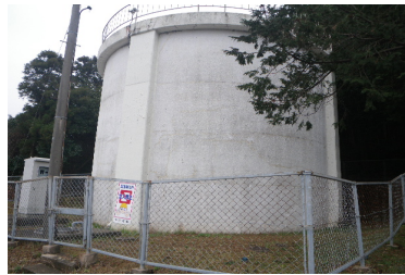
戸石川配水池
