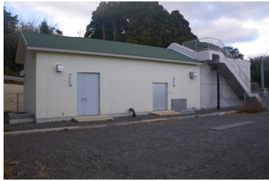
赤松中継ポンプ場
