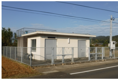
船越送水ポンプ場
