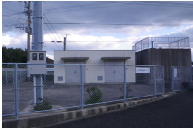
大久保中継ポンプ場
