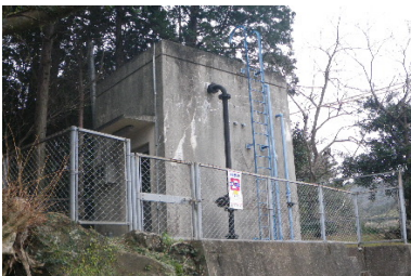
大野中継ポンプ場
