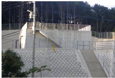
中南部配水池
