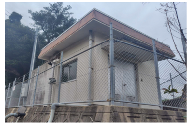
小手田中継ポンプ場
