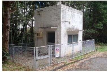
山中増圧ポンプ場
