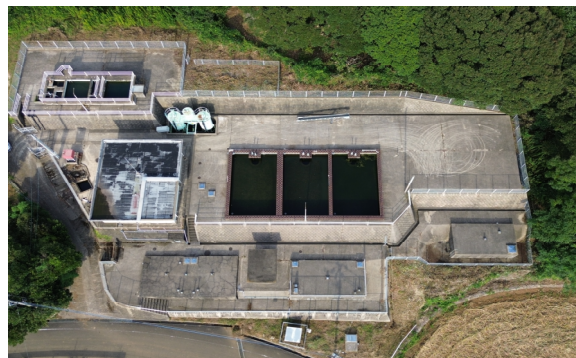
的山大島浄水場
