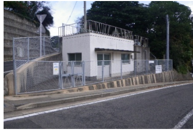
油水送水ポンプ場
