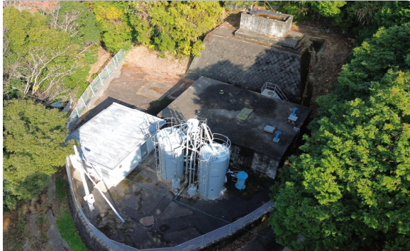
迎紐差浄水場
