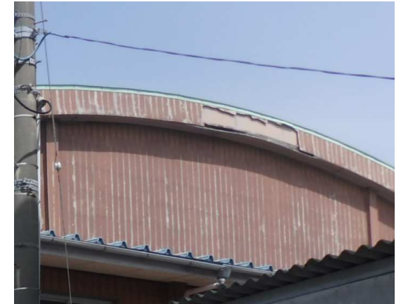
〈外壁の損傷〉
